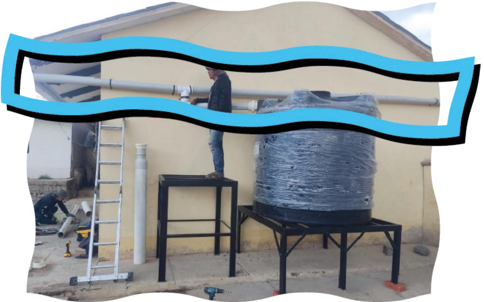
Las tuberías empleadas en el sistema son de PVC, con un diámetro de 4 pulgadas y de especificación clase 6, indicando un espesor aproximado de 3 mm. Estas características las vuelven óptimas para facilitar el flujo del agua desde las canaletas hacia el filtro de primeras lluvias y, posteriormente, hacia el tanque de almacenamiento.
